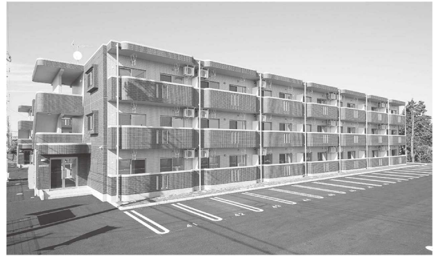
マンション施工例
